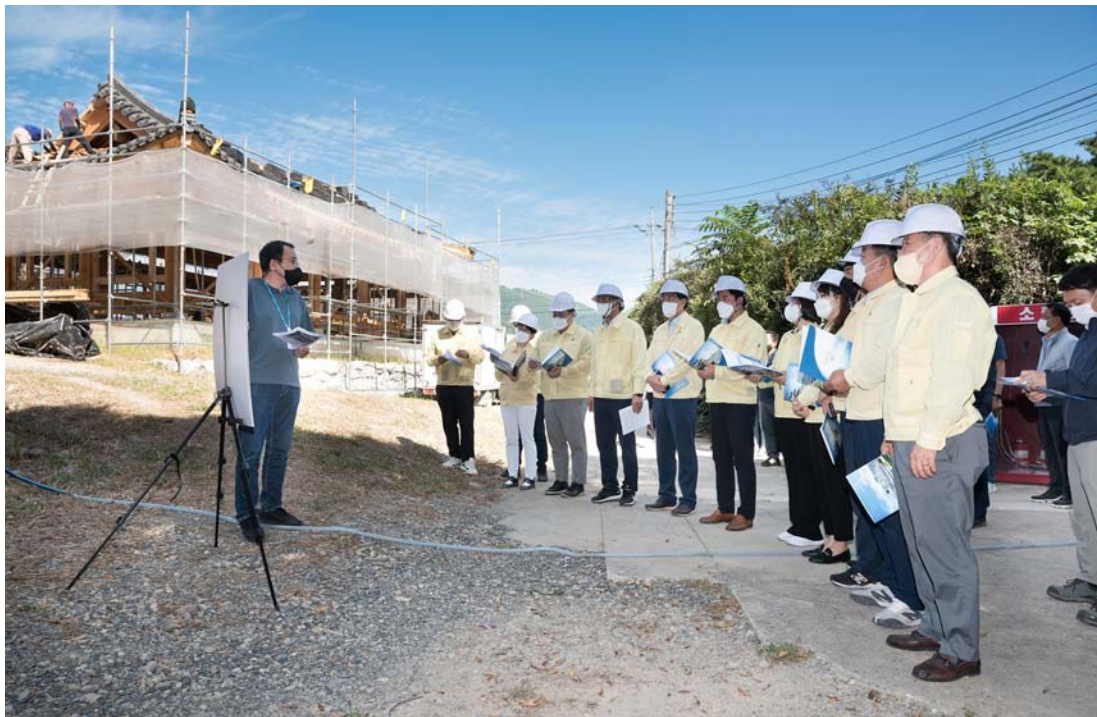
사업장 현장방문 (낙동가람 수변역사 누림길 조성사업)
